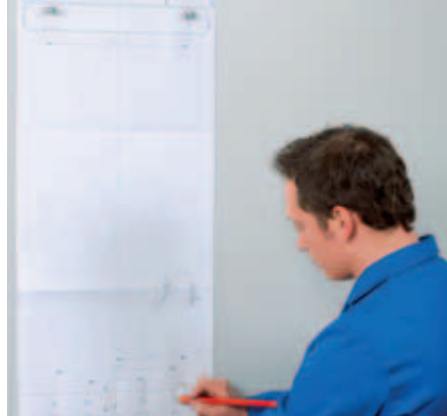
1. Príprava montáže pomocou montážnej šablóny
